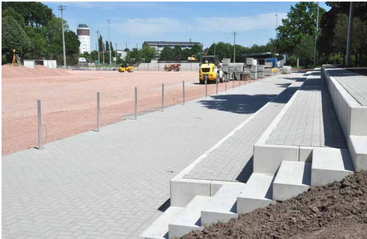
Noch rollen die Bagger. Aber Ende Juni sollen die Arbeiten an den beiden Kunstrasenplätzen des VfR Groß-Gerau abgeschlossen sein.
